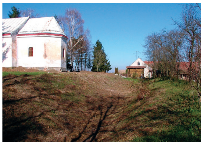
Sl. 7 Novi Pavljani, pogled s juĝa na istočni segment obrambenog jarka (snimila T. Tkalčec, 2002.).
