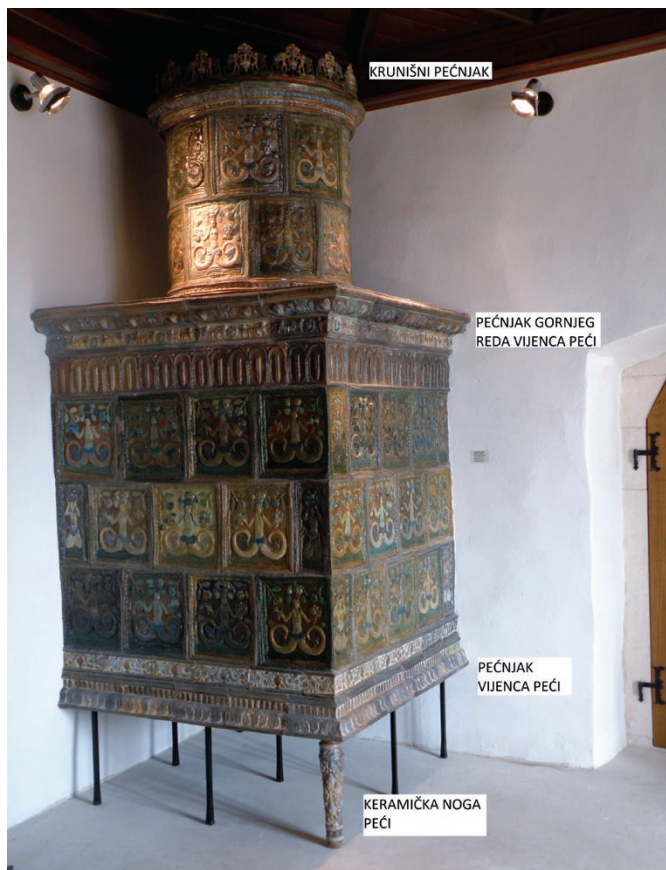
Sl. 3 Dvor Veliki Tabor, rekonstruirana kaljeva peć, oko 1600. (snimila I. Škiljan).
