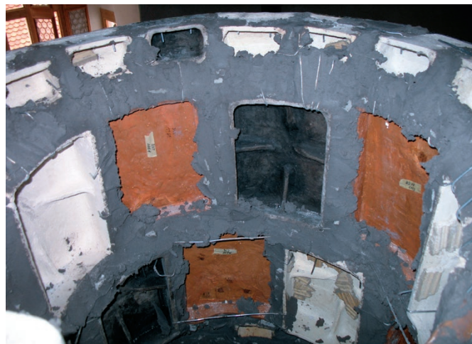
Sl. 3a Dvor Veliki Tabor, rekonstruirana kaljeva peć, oko 1600., unutrašnji dio peći prilikom izgradnje (snimila S. Antony Čekalova).
