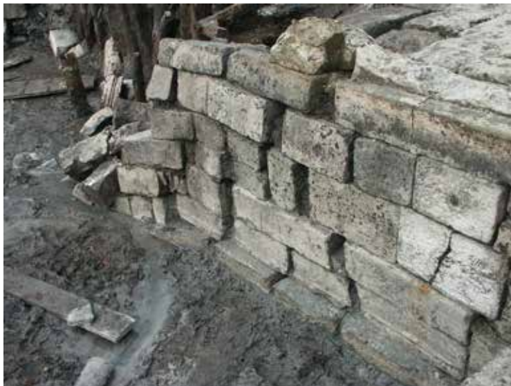
IZVORIŠNI BAZEN – SJEVERNI ZID SPRING POOL – NORTH WALL
