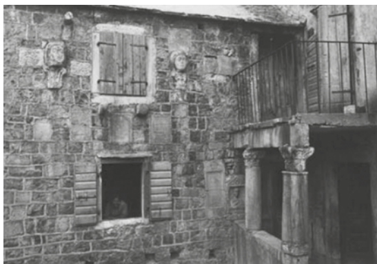
Sl. 10: Dio antičkih spolija uzidanih u kuću Benzon u Vranjicu (Fototeka Konzervatorskog odjela u Splitu).
