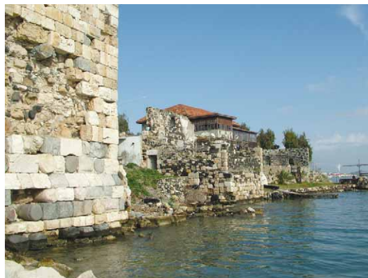
Figure 6 – City wall, East side, General view. Slika 6 – Gradske zidine. Pogled na istočnu stranu.
