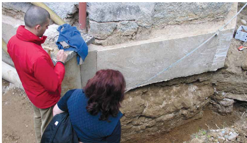
Slika 3 – pogled na temelje i betonsku oblogu u sondi 2b (foto – A. Azinović Bebek 2006).
