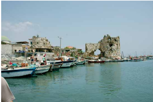
Figure 8 – City wall, South side, General view Slika 8 – Gradske zidine. Pogled na južnu stranu.
