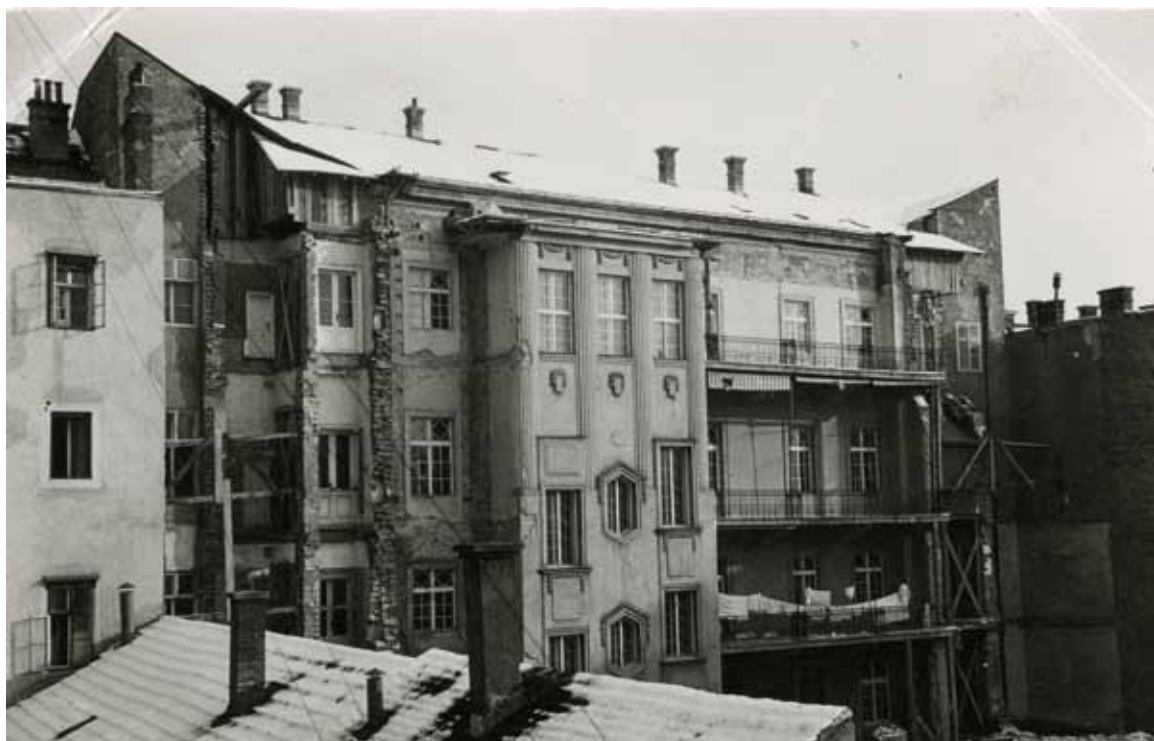
Sl. 7: Rušenje dvorišnih krila, 1941., MGZ FOT-17371 (Koprčina 2016: 213).
