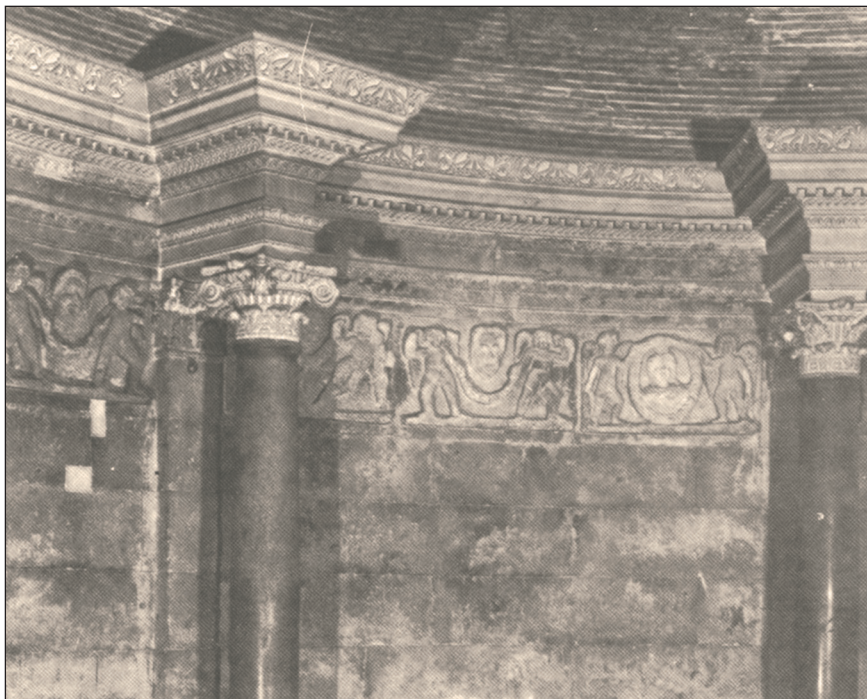
sl. 1. Unutrašnjost Dioklecijanova mauzoleja
