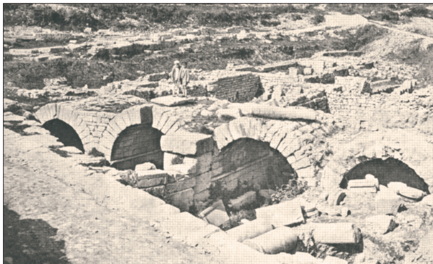
sl. 5. Lukovi mosta preko rukava Jadra – istoč- no od “ Pta Caesa- rea ” – s ostacima keja i s kasnijim radioničkim kompleksom
