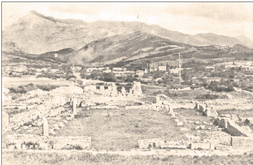
sl. 2. Velika sjeverna (epi- skopalna) bazilika, poslije izvedene konzervacije
