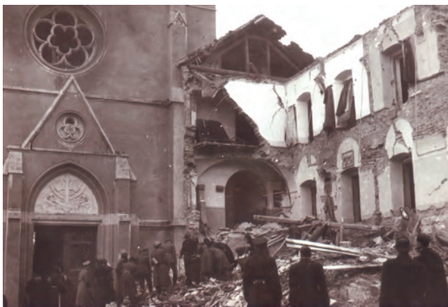
Sl. 7/8/9 — Ruševine refektorija samostana sv. Franje i njihovo raščišćavanje nakon savezničkog bombardiranja Zagreba 22. veljače 1944. godine. Foto: nepoznat (MGZ)
