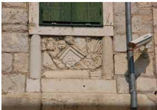
Sl. 8: Detalj na građevini kompleksa Tusculum u Saloni s ugrađenim antičkim spolijima (fotografirao: D. Demicheli).
