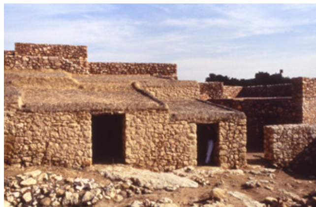
SLIKA 4. Krov kuće od gline i trske, rekonstruiran na lokalitetu Alorda Park, Calafell (M. C. Belarte).
