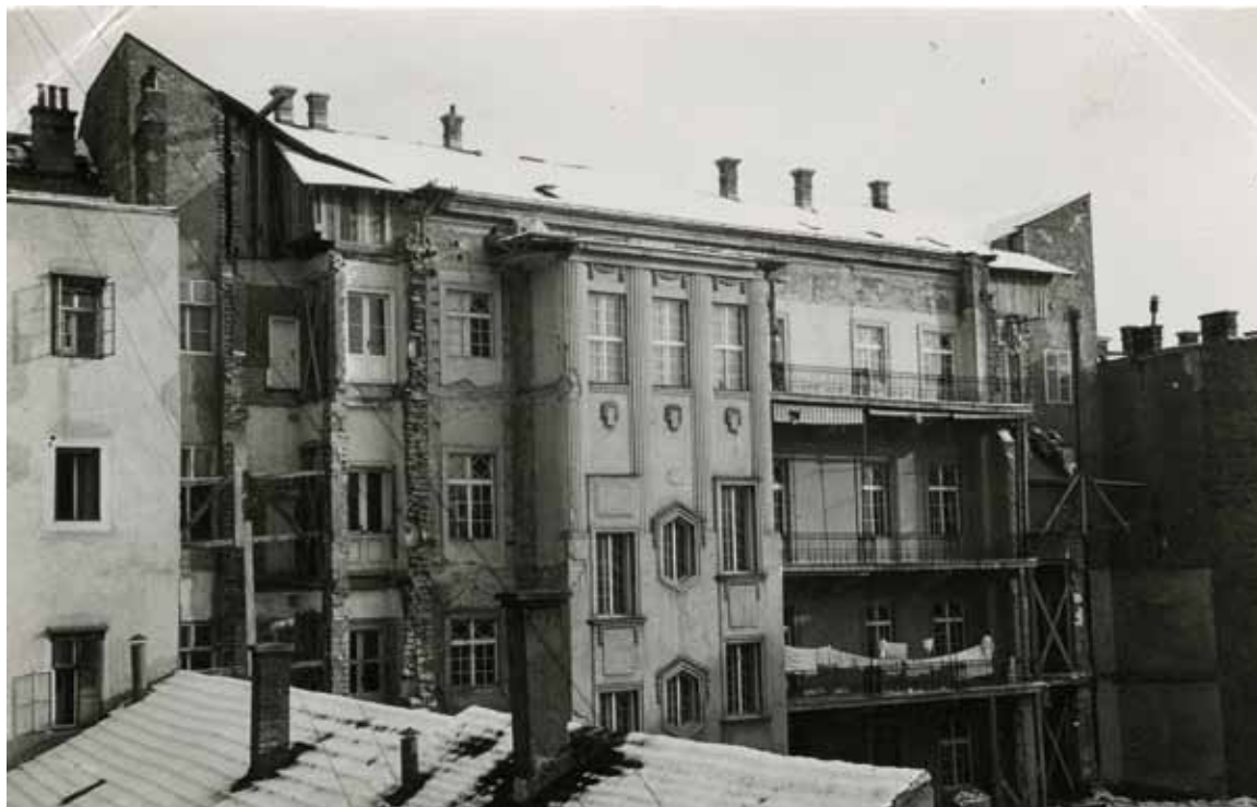
Sl. 7: Rušenje dvorišnih krila, 1941., MGZ FOT-17371 (Koprčina 2016: 213).
