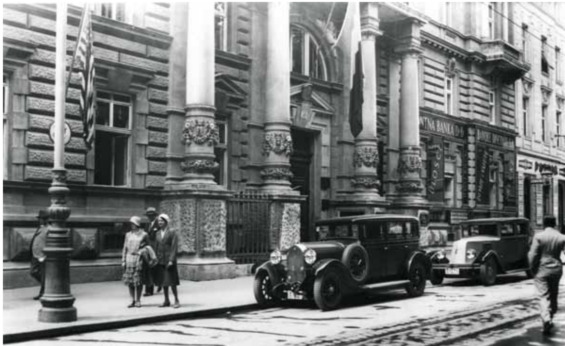
Sl. 6: Fotografija pročelja palače na Zrinjercu 19, 1929. – 1931., MGZ FOT-19997 (Koprčina 2016: 208-209).
