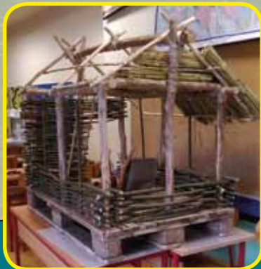
Dovršena osnovna struktura kuće za radionicu
