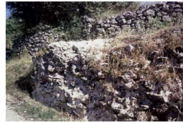
Abb. 4. Die westliche Wehrmauer.
