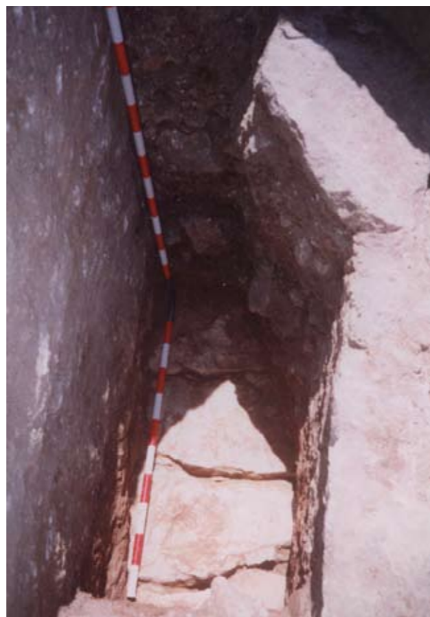
Abb. 13 b. Abflußkanal der Zisterne (GAR00-4-35).
