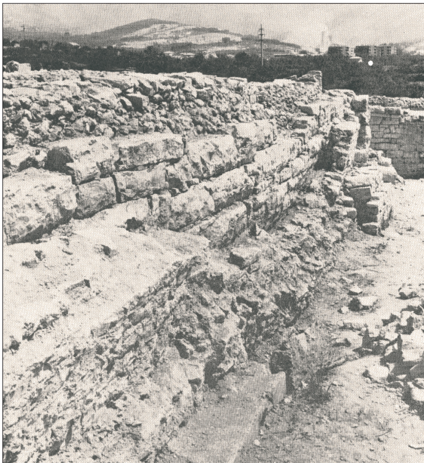
sl. 3. Dio novootvorenih sjevernih bedema staroga grada, uz kulu (unutrašnje lice)
