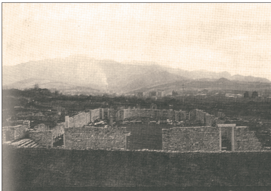
sl. 9. Episkopalna bazilika nakon djelomične, neadekvatne restitucije
