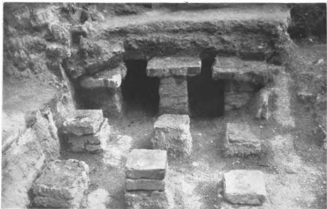
59. Pogled na istu prostoriju sa zapadne strane. 60. Detalj oštećenog poda i hipokausta u istoj prostoriji.
