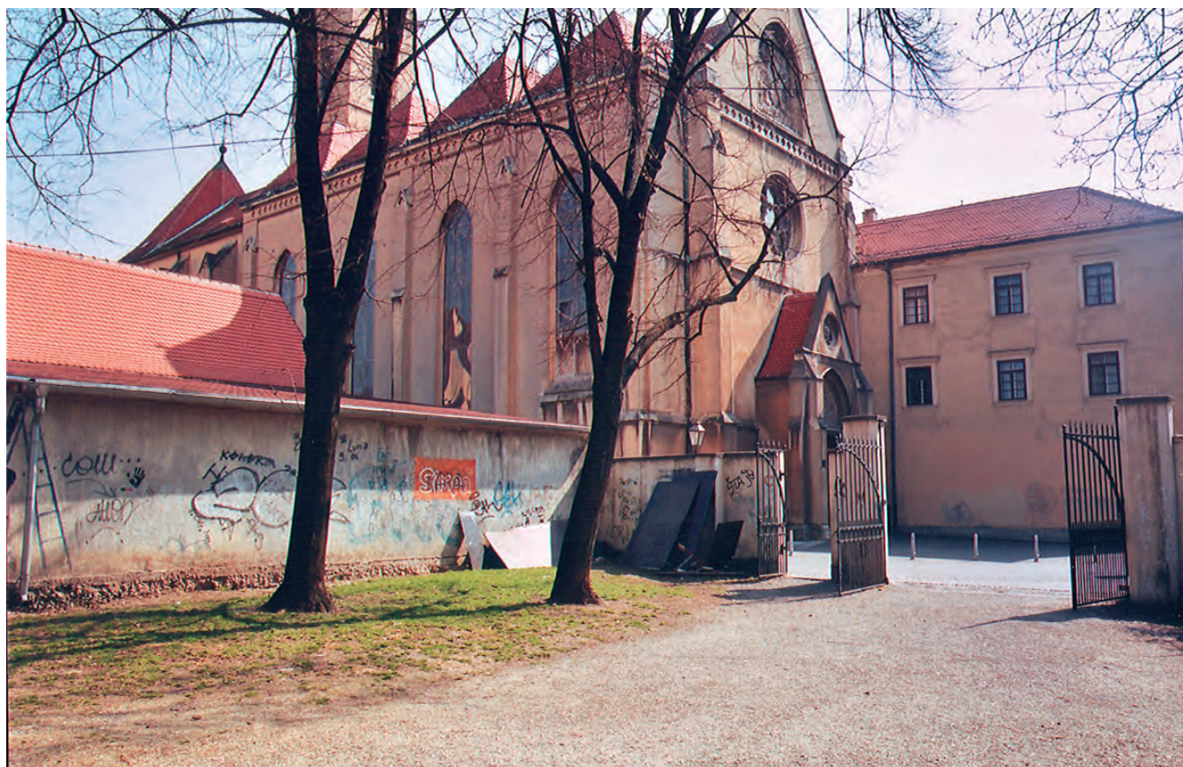
Sl. 92 — Pogled na crkvu sv. Franje i jugoistočni dio Parka Opatovine. Foto: Ž. Demo
