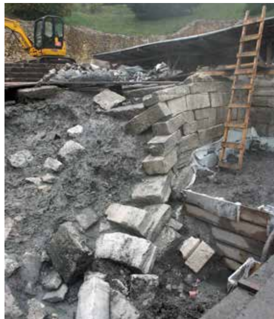
IZVORIŠNI BAZEN – SJEVERNI ZID (ISTRAŽIVANJA 2011. god.) SPRING POOL – NORTH WALL (EXCAVATIONS 2011)
