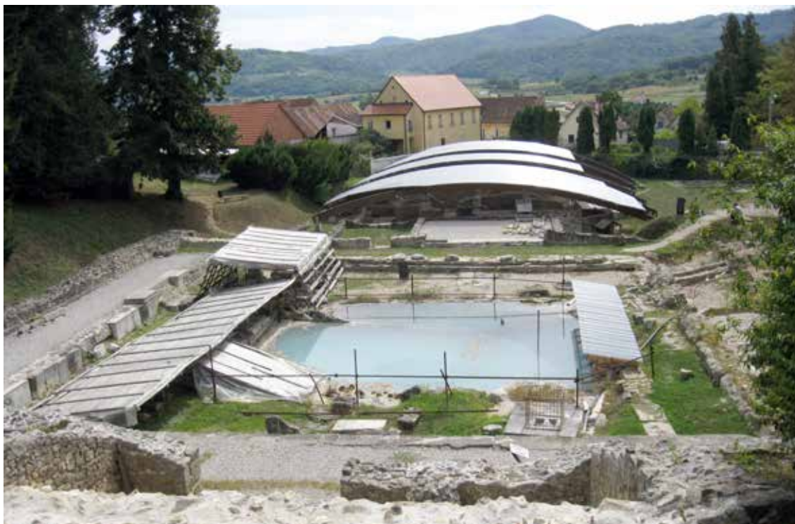
KOMPLEKS RIMSKE ARHITEKTURE U GRADSKOM PARKU (VARAŽDINSKE TOPLICE) ROMAN ARCHITECTURAL COMPLEX IN THE MUNICIPAL PARK (VARAŽDINSKE TOPLICE)
