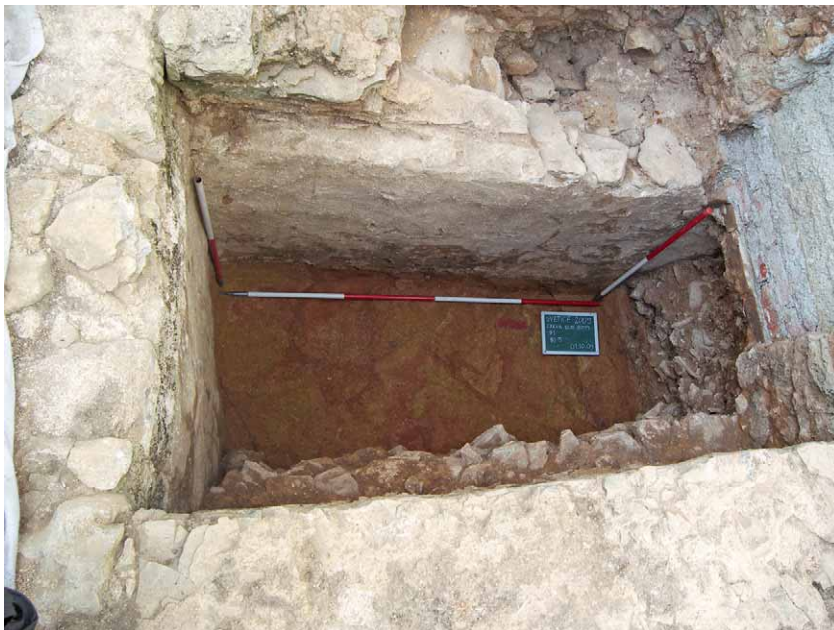
Slika 3 – Istraživani prostor unutarnje strane temelja zidova (foto: Ana Azinović Bebek, 2009.).
