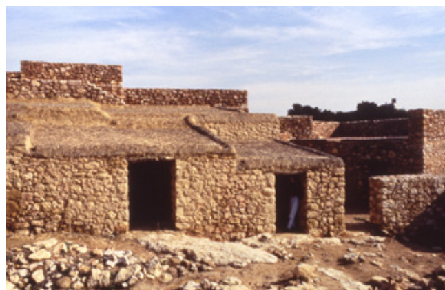
SLIKA 4. Krov kuće od gline i trske, rekonstruiran na lokalitetu Alorda Park, Calafell (M. c. Belarte).
