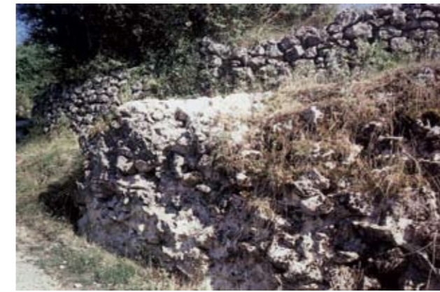
Abb. 4. Die westliche Wehrmauer.
