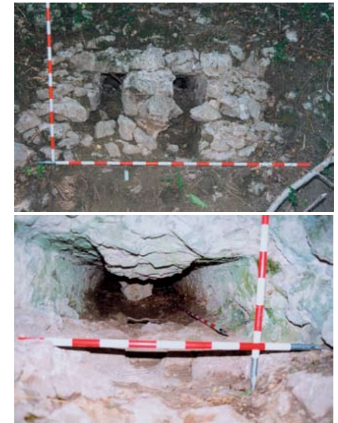
Abb. 5 a - b. Abdrücke massiver Holzbalken in der westlichen Wehrmauer.
