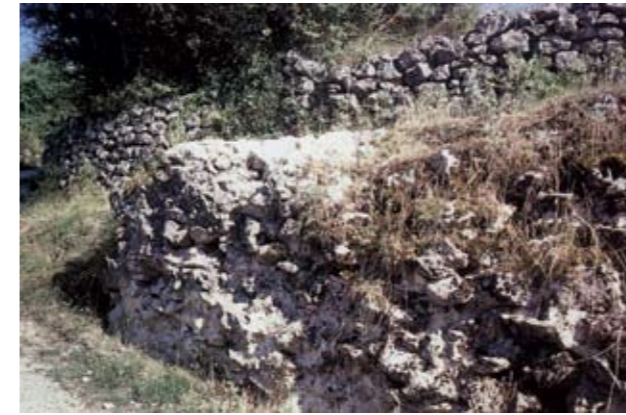
Abb. 4. Die westliche Wehrmauer.
