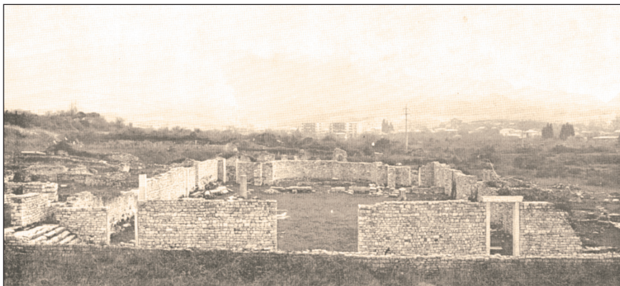
sl. 21. Velika, sjeverna, episkopalna bazilika, prije izvedene kon- zervacije (u pozadini istočne terme)
