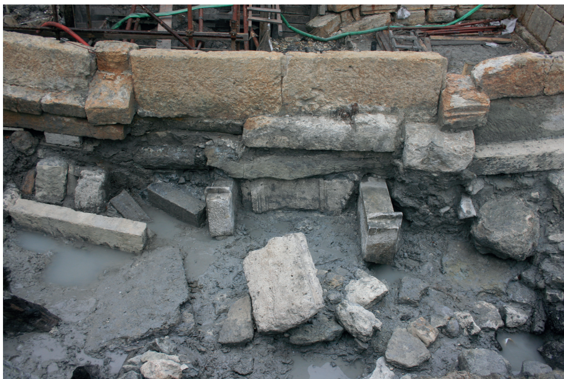
Slika / Figure 9: Pogled na južni zid izvorišnog bazena s vidljivom konstrukcijom zida sa sekundarno upotrebjenim spomenicima, tijekom istraživanja prostora južno od izvorišta 2011. god. (snimila D. Nemeth-Ehrlich). / Southern wall of the spring reservoir with a wall constructed of reused monuments during the 2011 excavations of the area to the south of the spring (photo by D. Nemeth-Ehrlich).
